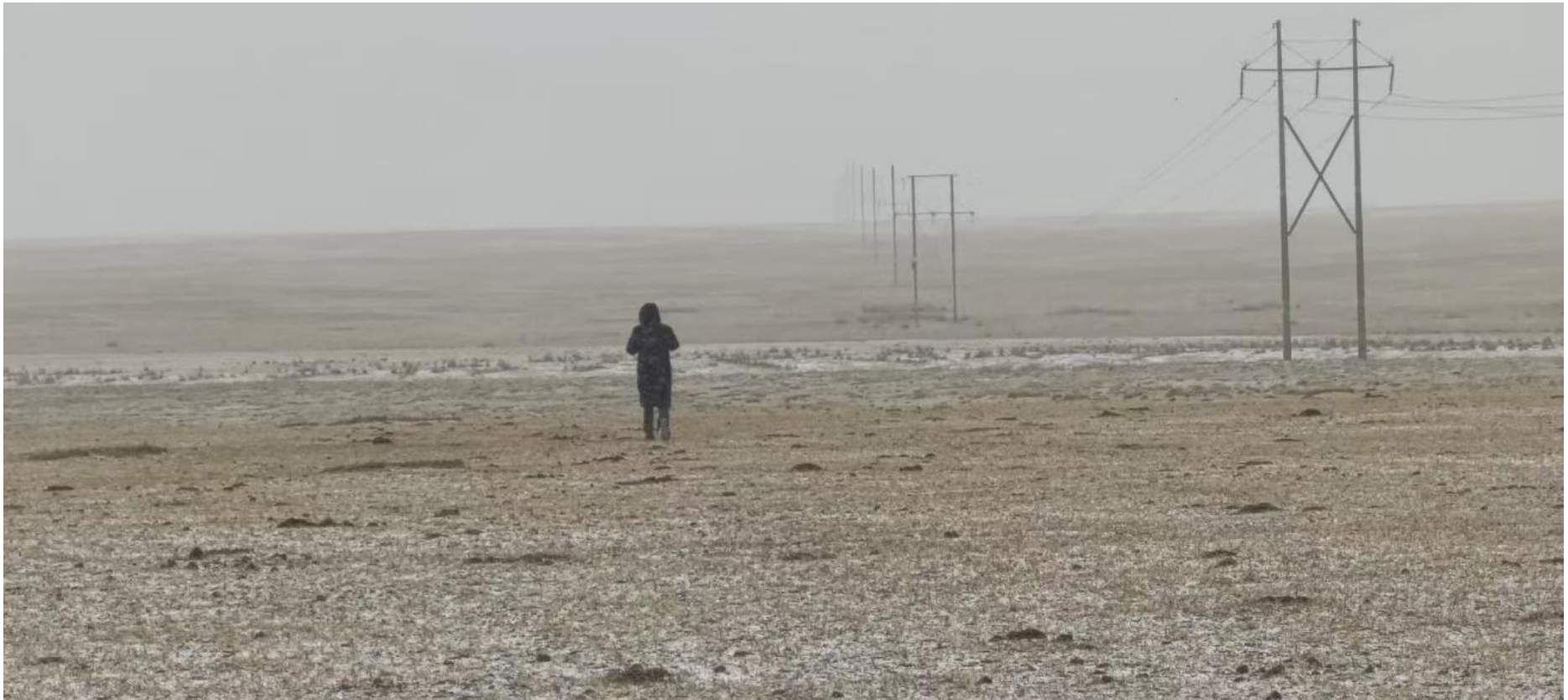
图 2-12 线路所跨越坑塘现状为干涸洼地
