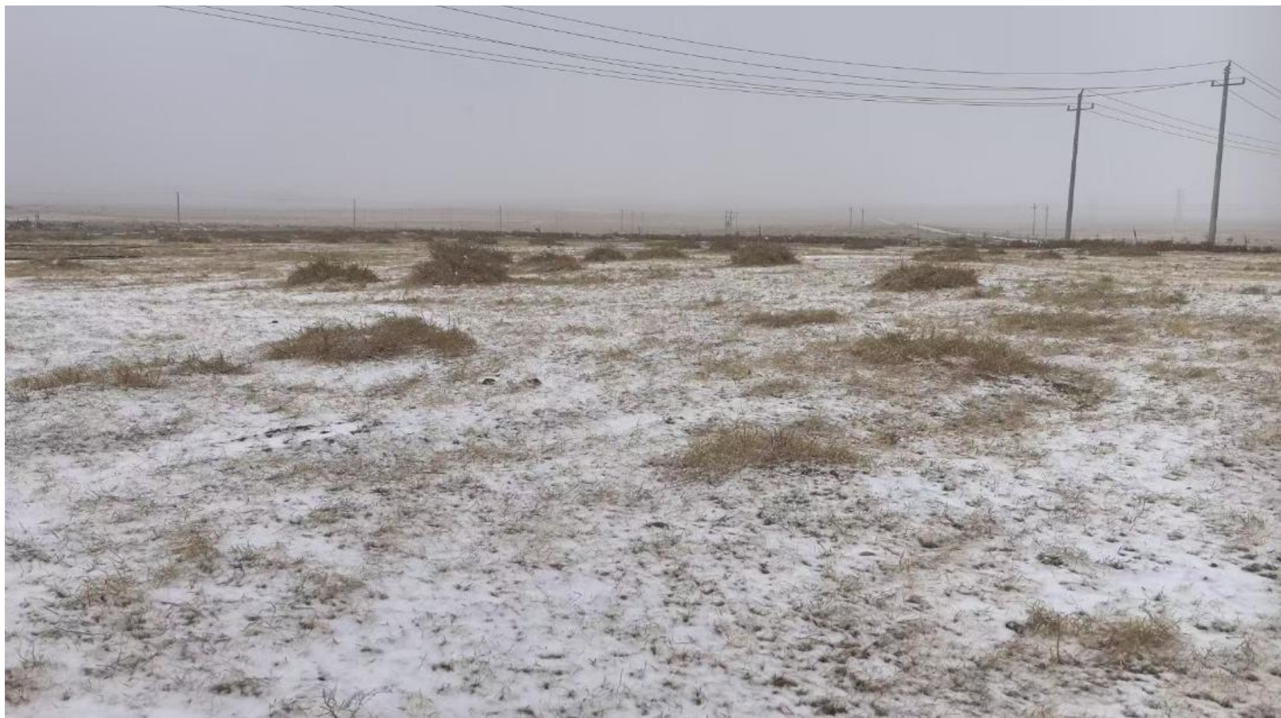
图 2-19 乌兰 110kV 变电站本期扩建间隔出线方向（与远处线路伴行）
