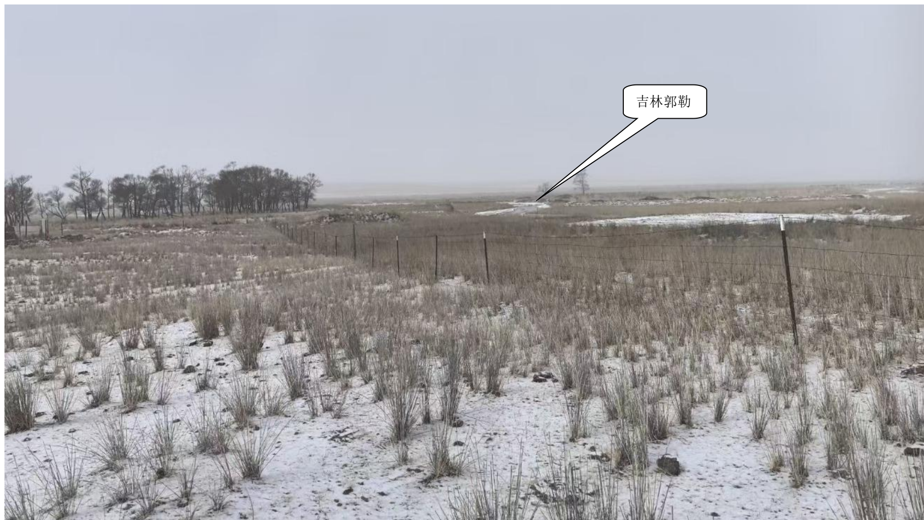
图 2-9 线路跨越吉林郭勒河现状
