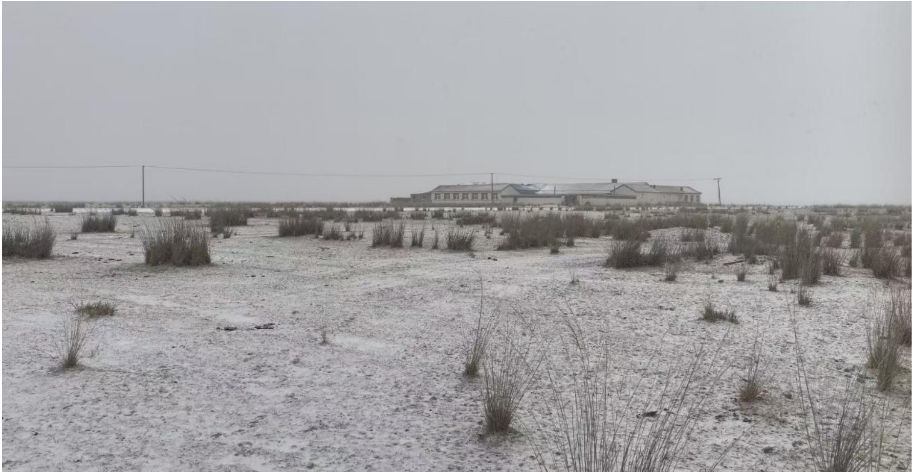
图 2-6 吉林郭勒 110kV 变电站西北侧牧户
