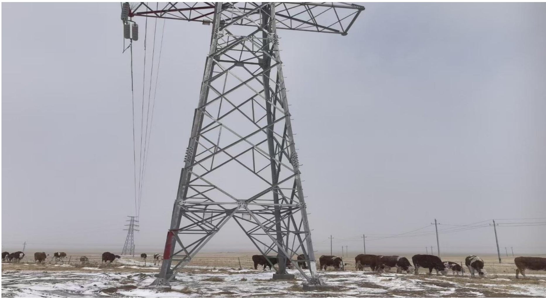
图 2-19 乌兰 110kV 变电站本期扩建间隔出线方向
