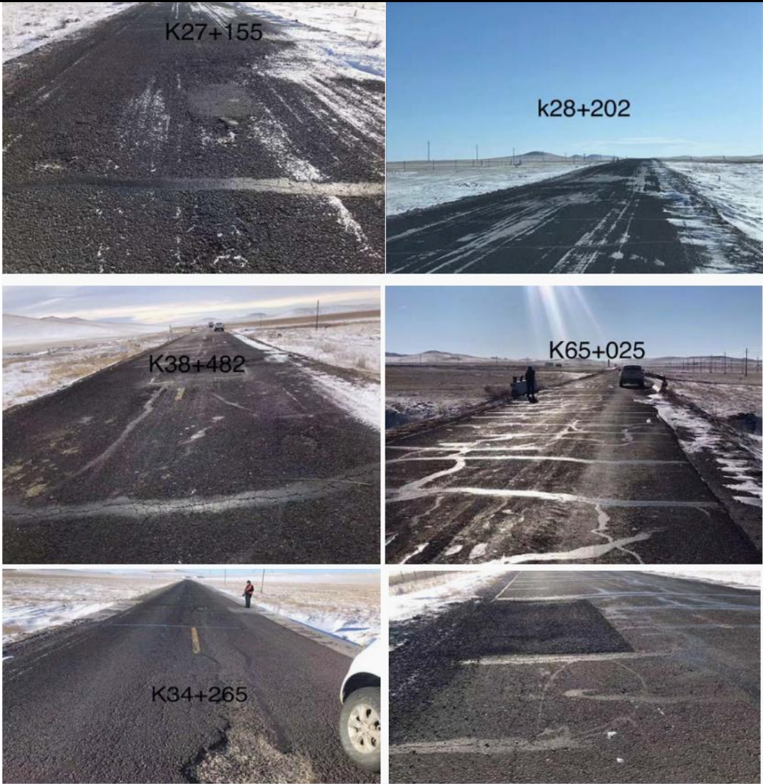
图 2 现有公路路面状况
